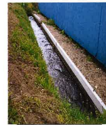
嵩上げ工事(開田)
