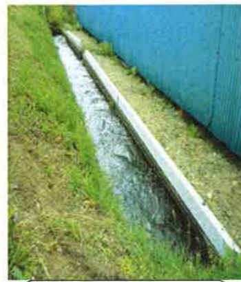
嵩上げ工事（開田）
